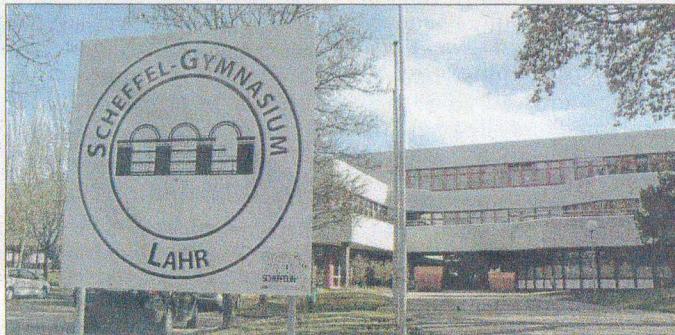
In den Osterferien wird im »Scheffel« saniert. Archivfoto: Haid
